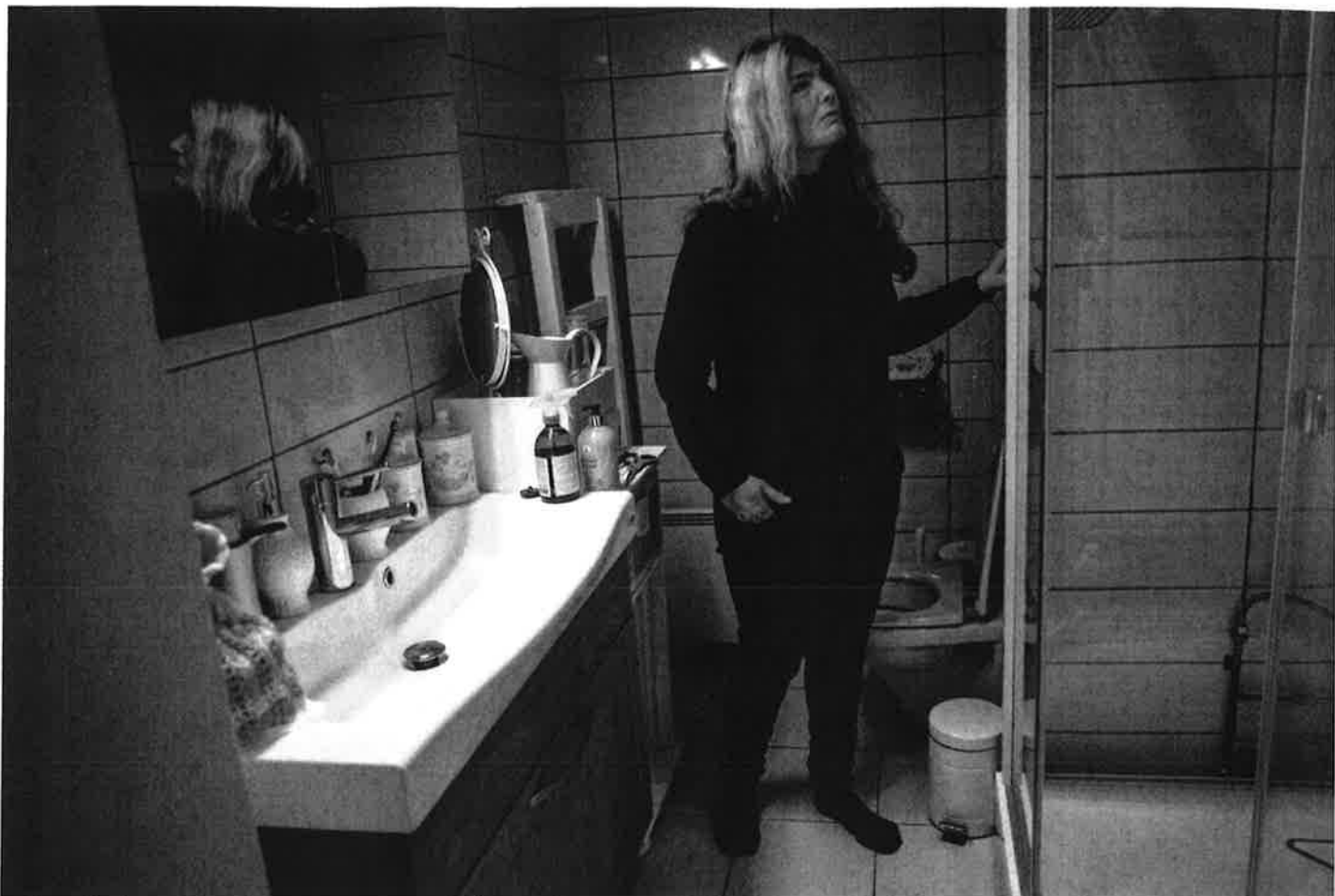
VANNSKADE: Kort tid etter at Anitha Ervik overtok ny bolig i Halden i 2010 ringte naboen på døren og fortalte at det lekker inn vann hos ham n hun dusjer. Ervik forteller at advokaten i Help Forsikring krevde at Våtrom Entreprenøren i Drammen skulle undersøke tilstanden på badet.
